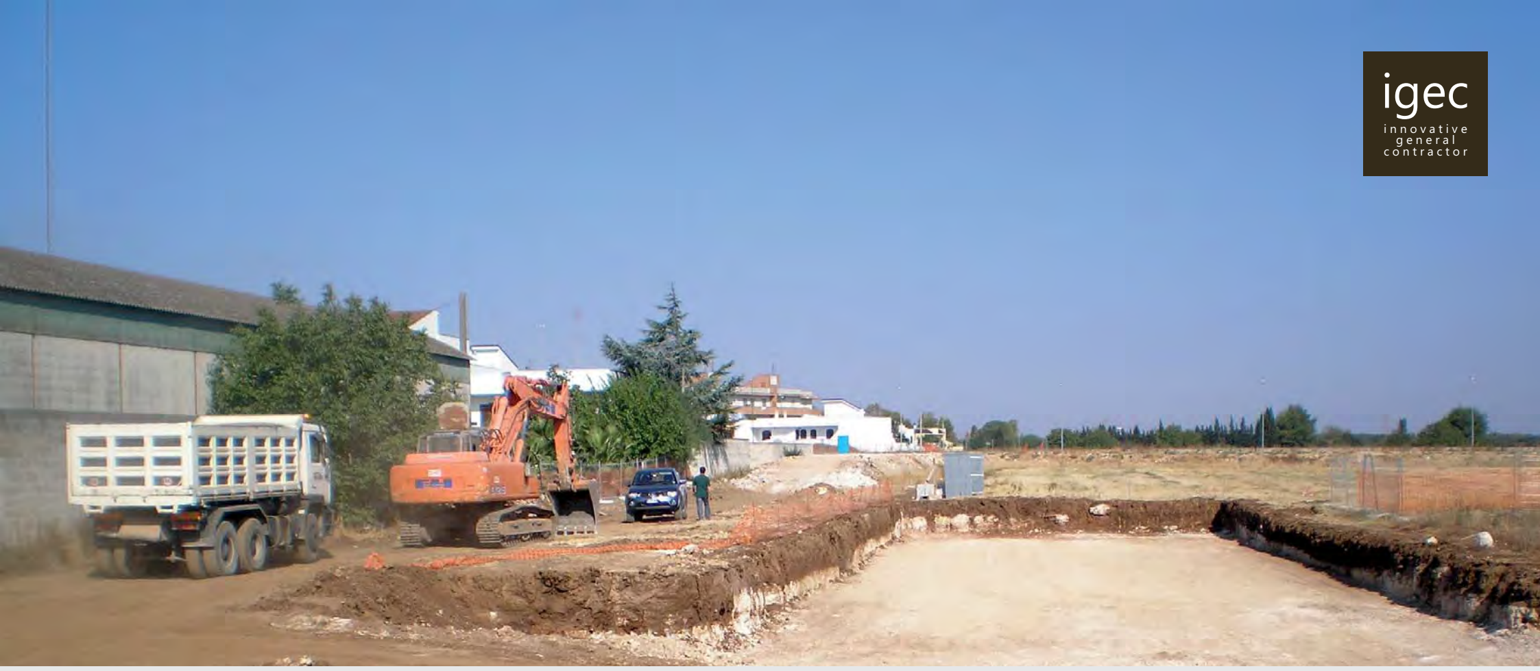
Alcune opere di movimento terra
