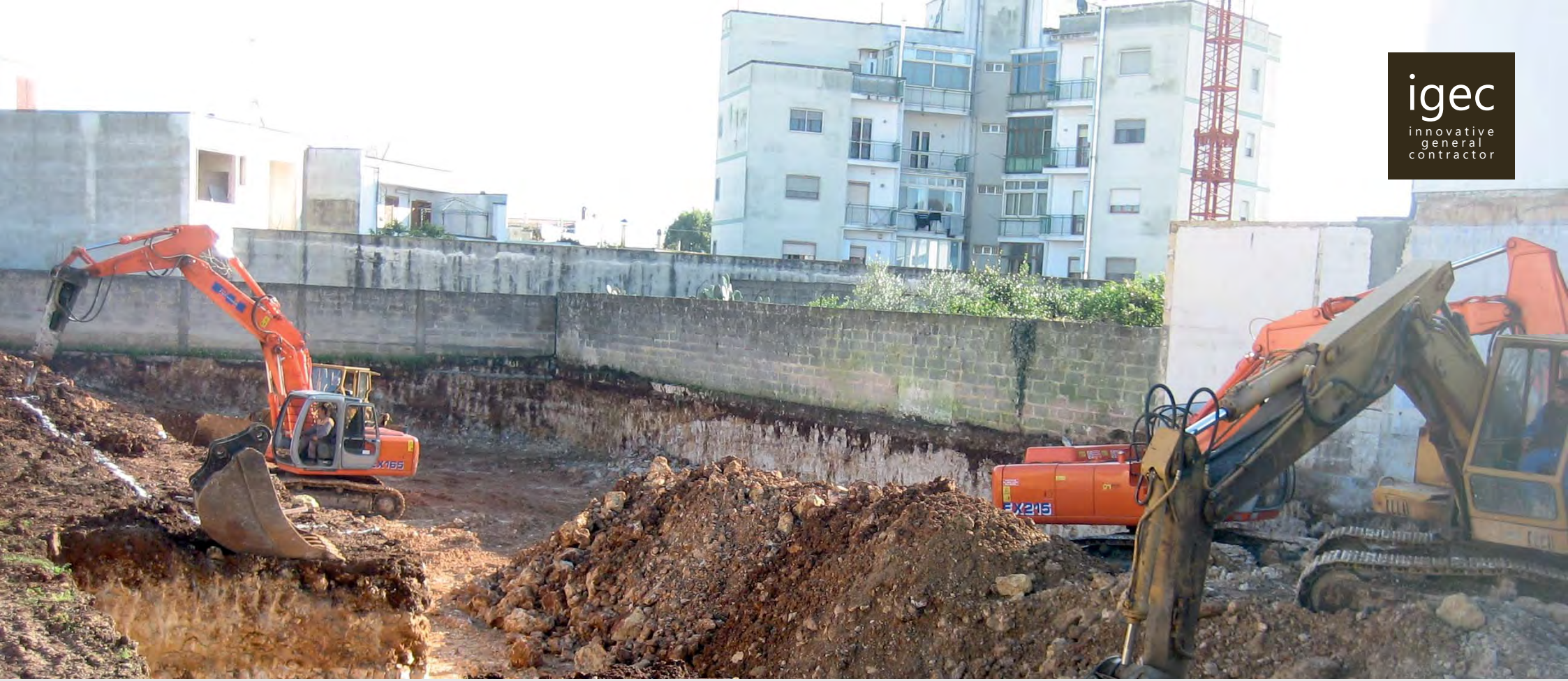
Alcune opere di movimento terra
